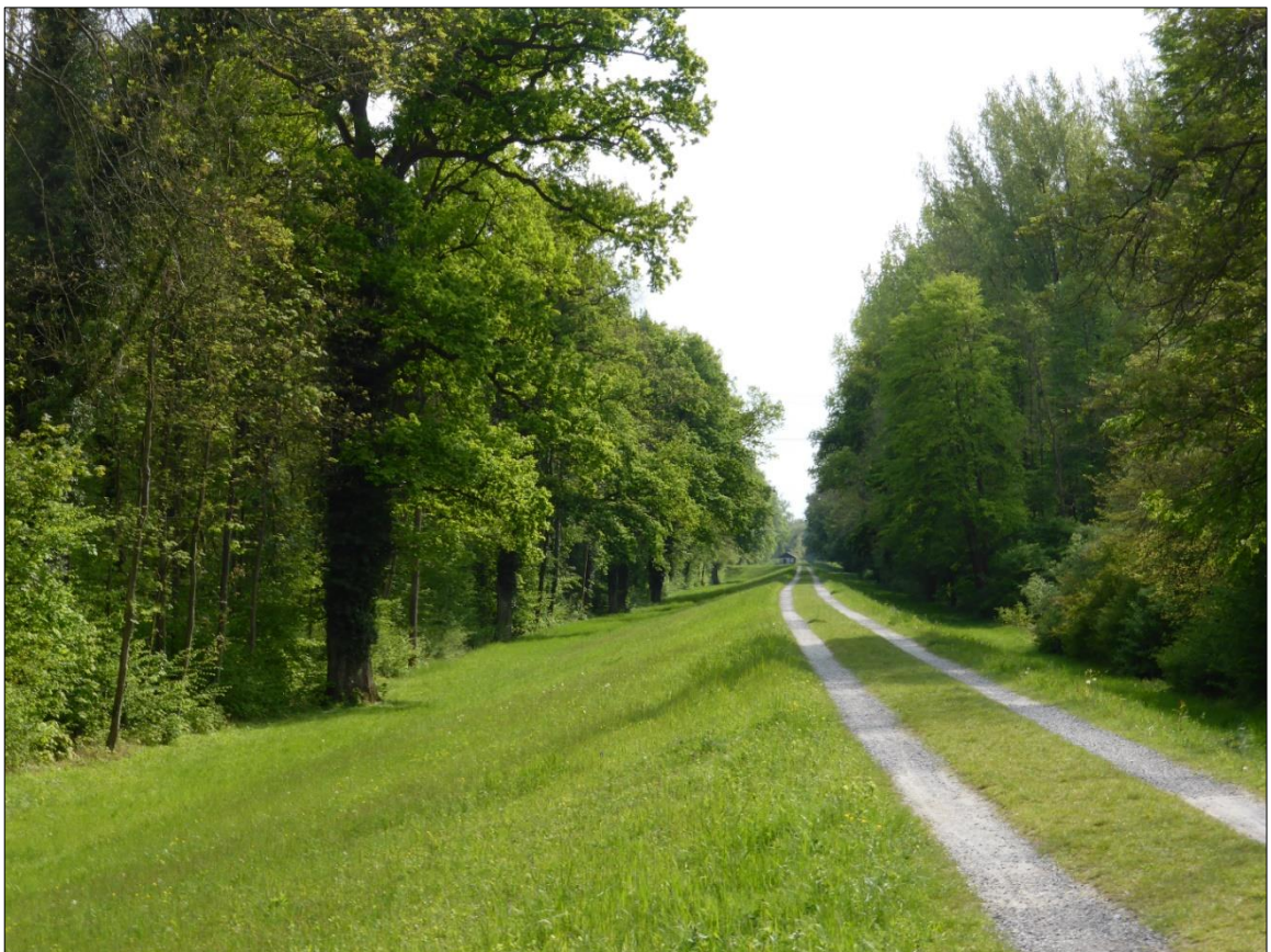
Abbildung 4.2-2: Dammabschnitt zwischen Bauwerk 5 und Waidweg, Standort bei km18+480, Blick entlang der polderseitigen Böschung nach Südwesten in Richtung Waidweg.
