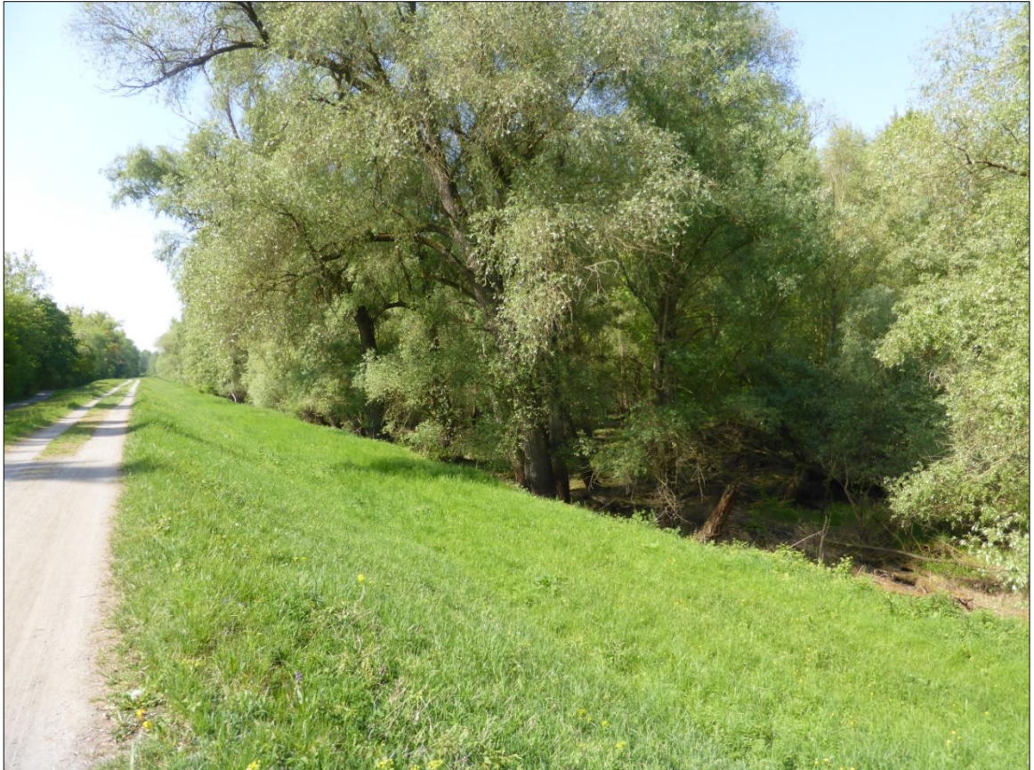
Abbildung 4.2-1: Rheinseitige Böschung des HWD XXV bei km 14+250, Blick entlang der Böschung nach Südwesten.
